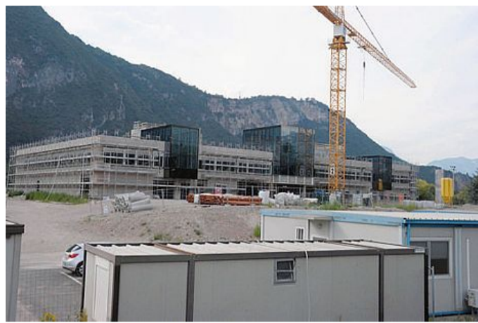
Il nuovo ospedale sorgerà in via delle Ghiaie
